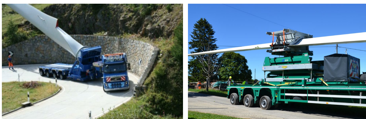
Figure 20: Transport modulaire d'une pale au col de Gries (CH), (Source : Suisse Eole). Transport spécial avec "ascenseur" (Repowering Juvent, 2016), (Source : ennova)
